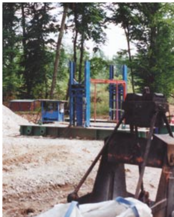
Abb. 44, Baustelle Tiefbrunnen im Forchheimer Wald
