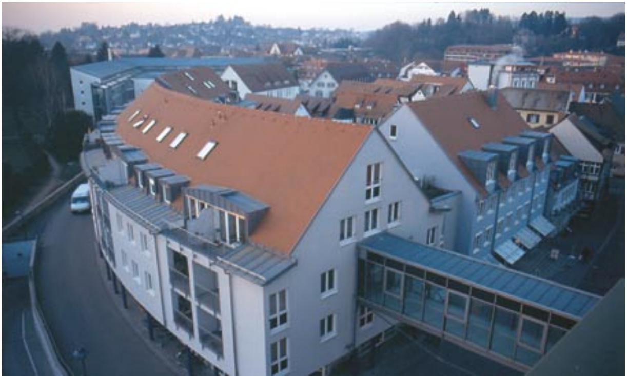
Abb. 125, Westend – Gebäude des Landratsamtes
