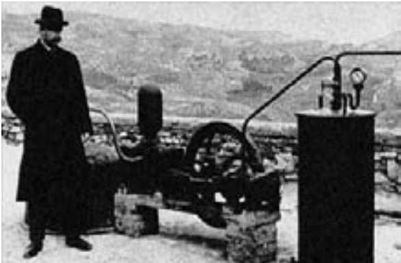
Abb. 83, Erdwärmeheizung 1904 von Larderell
