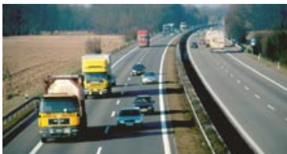
Abb. 36, Autobahn bei Kenzingen
