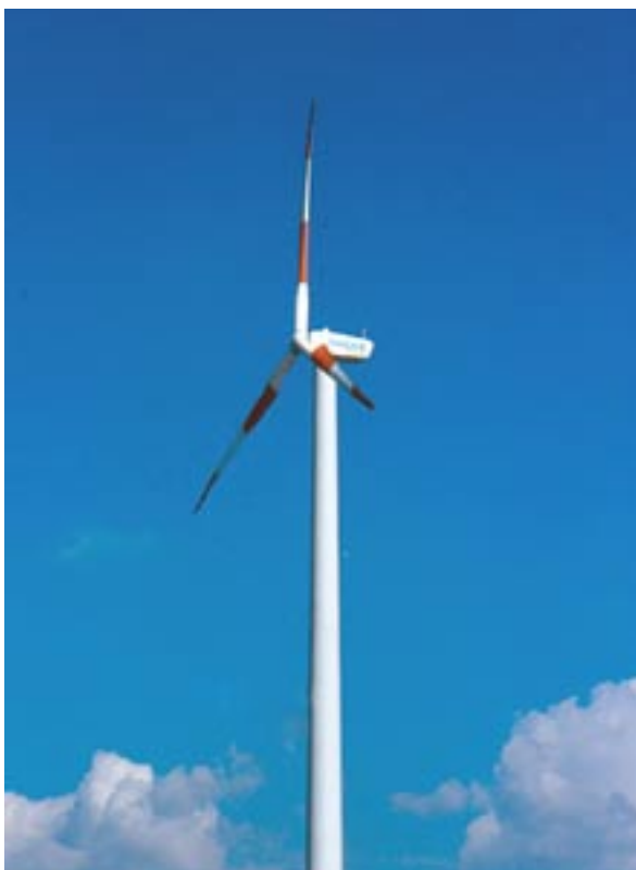
Abb. 82, Windkraftanlage beim Rasthof Herbolzheim
