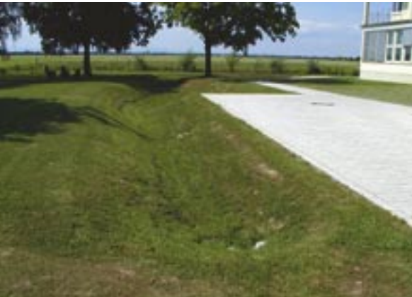
Abb. 65, Dezentrale Muldenversickerung
