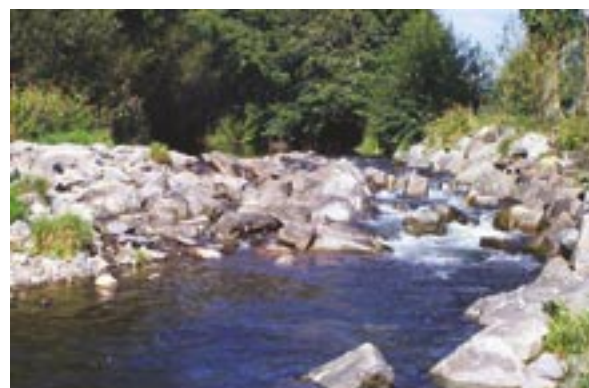
Abb. 54, Durchgängigkeit durch eine „Rauhe Rampe“
